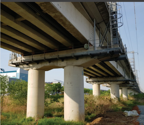
호남선 광주송정-노안간 황룡강교 교량받침장치 보수공사
