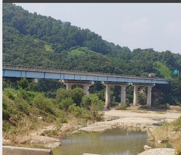
국도3호선 청미천교 내진보강공사
