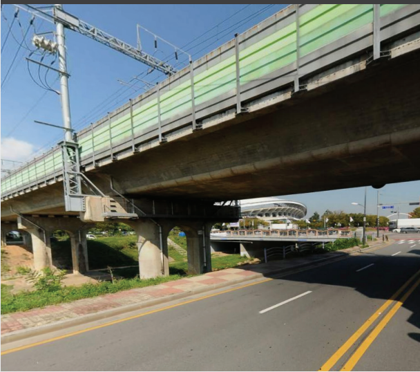
안산선 반월고가교 및 삼천고가교 내진성능 보강공사
