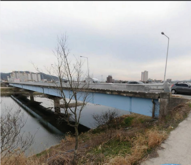
나주 중앙교 보수보강공사 (교량승상 500mm)
