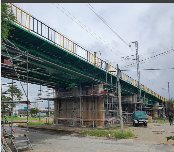
경부선 조치원-내판간 미호천교(상) 외 2개소 교량보강공사
