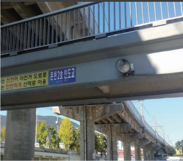
세병교 외 3개소 내진보강공사 (교량승상 500mm)
