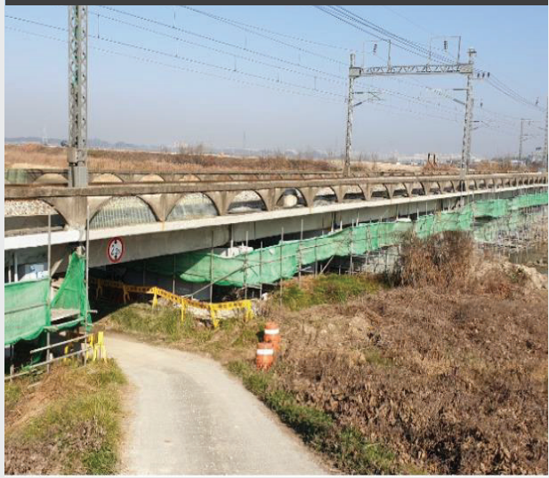
호남선 김제-신태인역간 원평천(복)보강공사
