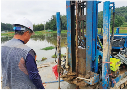
01 장비 설치 및 천공
